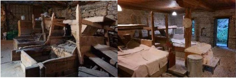
Şekil 14. Safranbolu Dereköy Değirmeni İç Mekânı ve Geleneksel Üretim Donanımları (Şahin vd, 2022).
