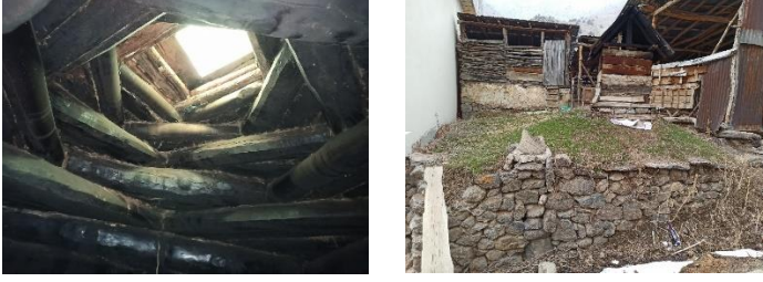
Görsel 14 (a, b): a) Kare kırlangıç kubbesi. b) Dış cephe görünümü. Fotoğraf: Hasan SÖYLEMEZ
