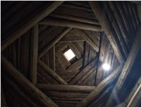
Görsel 18 (a, b): a) Kırlangıç kubbe. b) Sonradan eklenen kısımda pasin örtüşü. Fotoğraf: Hasan SÖYLEMEZ
