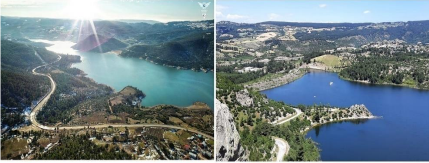
Şekil 6. Atikhisar Barajı ve Kalesi'nin Drone görüntüleri. (Atikhisar, 2022).
