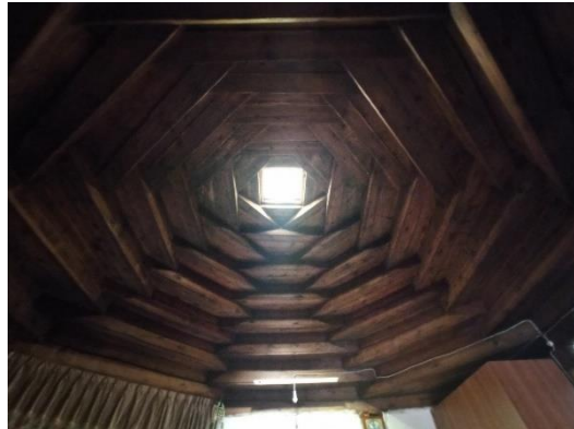
Görsel 8 (a, b): a) Kırlangıç kubbe ile örtülü ana mekan. b) Kırlangıç kubbe. Fotoğraf: Hasan SÖYLEMEZ
