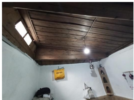
Görsel 18 (a, b): a) Kırlangıç kubbe. b) Sonradan eklenen kısımda pasin örtüşü. Fotoğraf: Hasan SÖYLEMEZ
