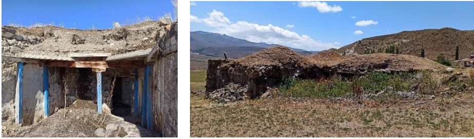
Görsel 2 (a, b): a) Kırlangıç kubbenin üzerindeki toprak katmanı b) Kırlangıç kubbeli bir evin dışarıdan görünüşü, Fotoğraf: Hasan SÖYLEMEZ
