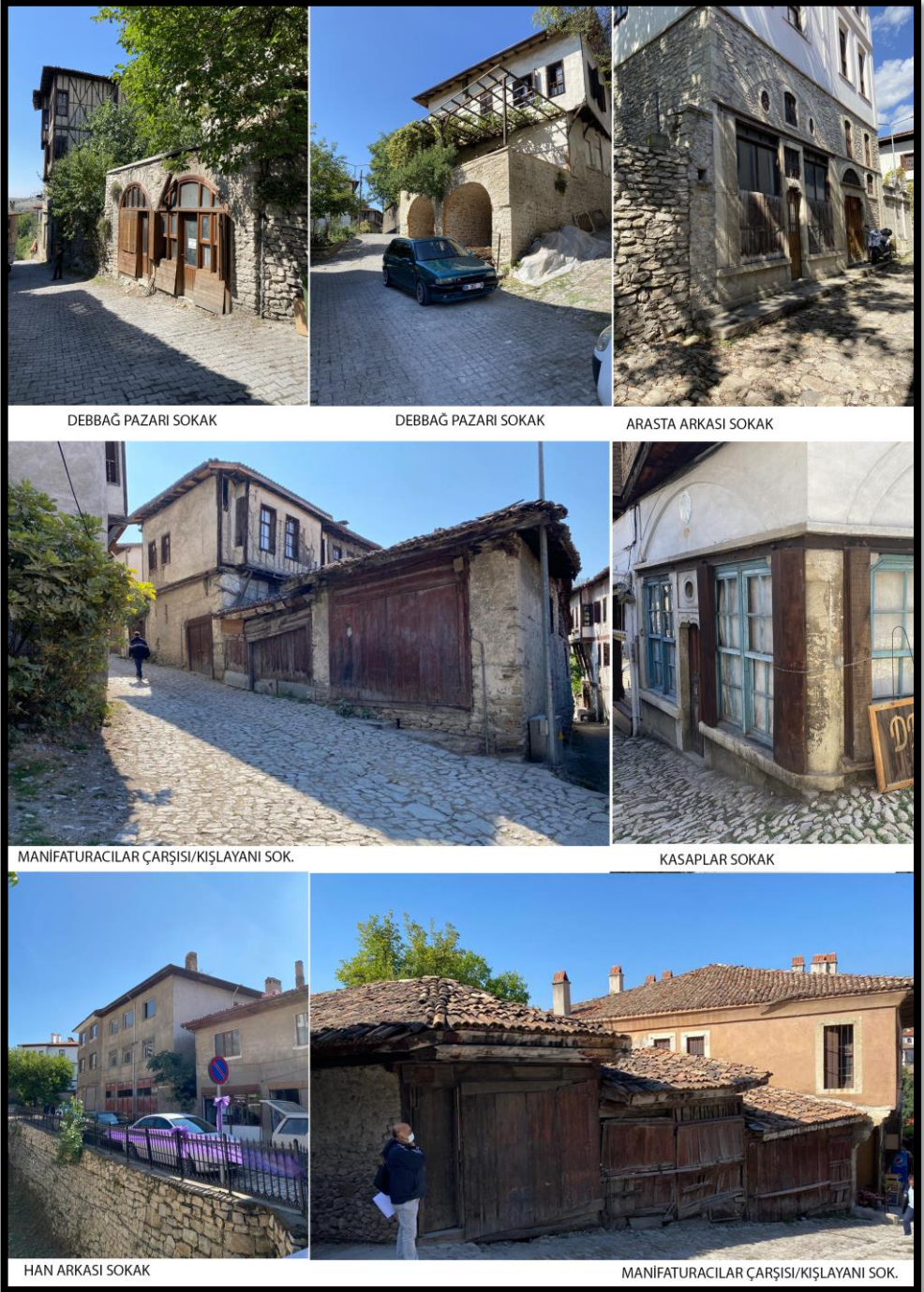
Şekil 8. 21. yüzyıl ilk çeyreğinde Safranbolu Çarşısı'ndan sokak görünüşleri; Debbag Pazarı, Arasta Arkası, Manifaturacılar Çarşısı/Kışlayanı, Kasaplar ve Han Arkası sokakta boş-kapalı/depo /yıkık haldeki yapılar (Şahin vd, 2022).
