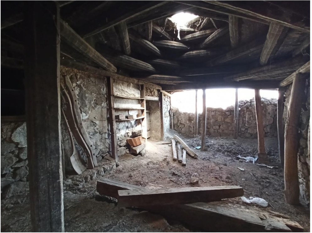
Görsel 3: Mekâna hâkim bir unsur olarak kırlangıç kubbe (arka cephenin duvarı zaman içerisinde yıkılmıştır). Fotoğraf: Hasan SÖYLEMEZ
