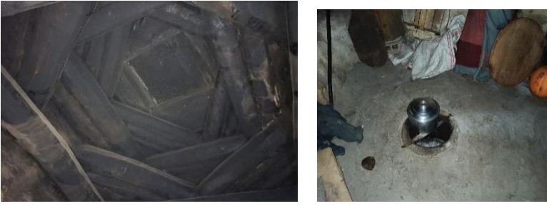
Görsel 15 (a, b): a) Tandır ocağı. b) Tandır ocağını örten kırlangıç örtü. Fotoğraf: Hasan SÖYLEMEZ
