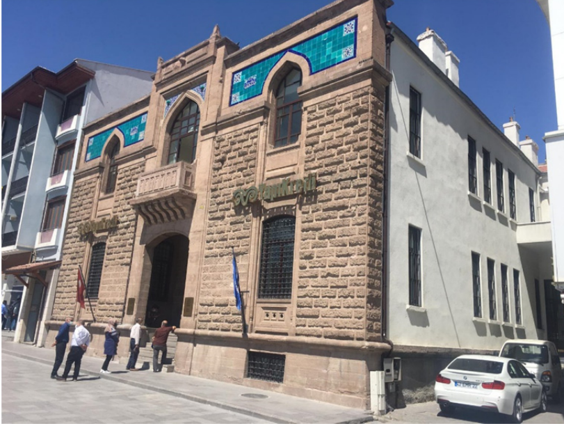
Şekil 18. Osmanlı Bankası binası giriş cephesi görünümü (Yağcı, 2021)
