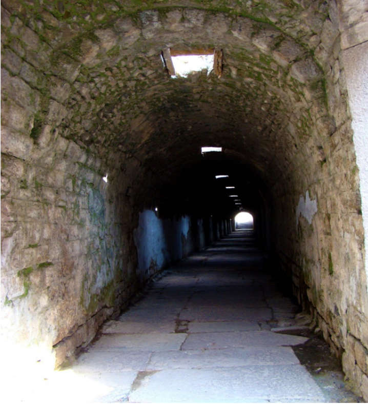
Şekil 8. Yeraltı Geçit Tüneli (Kaynak: Tronchin, F. C., 2011)
