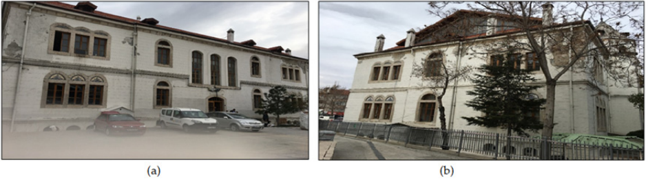
Şekil 16. Sanayi Mektebi kuzey (a) ve doğu cephesi görünümü (Yağcı 2021)
