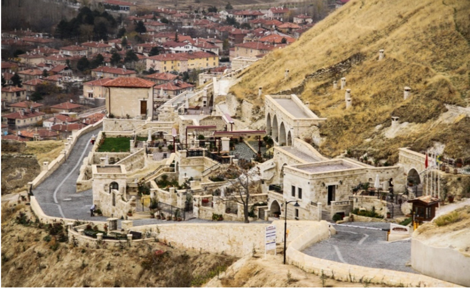
Görsel 6. Kayakapı Mahallesi'nin koruma uygulaması sonrası görünümü (Kayakapı Arşivi)
