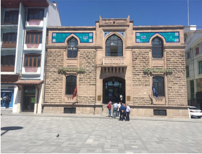
Şekil 21. Osmanlı Bankası binası giriş cephesi görünümü (Yağcı, 2021)
