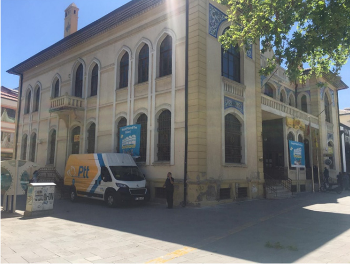
Şekil 4. Konya Postane Binası cephe fotoğrafı (Yağcı, 2021)
