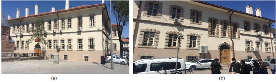
Şekil 28. Hükümet Konağı binası batı (a) ve güney cephesi görünümü (Yağcı, 2021)
