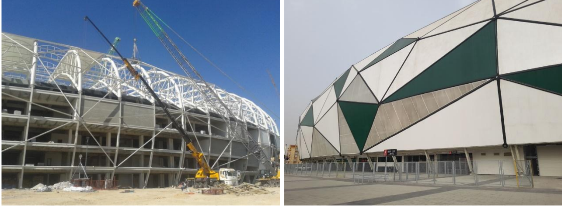
Resim 18 ve 19. Yapım Sürecinden ve Dış Cepheden Görüntüler
