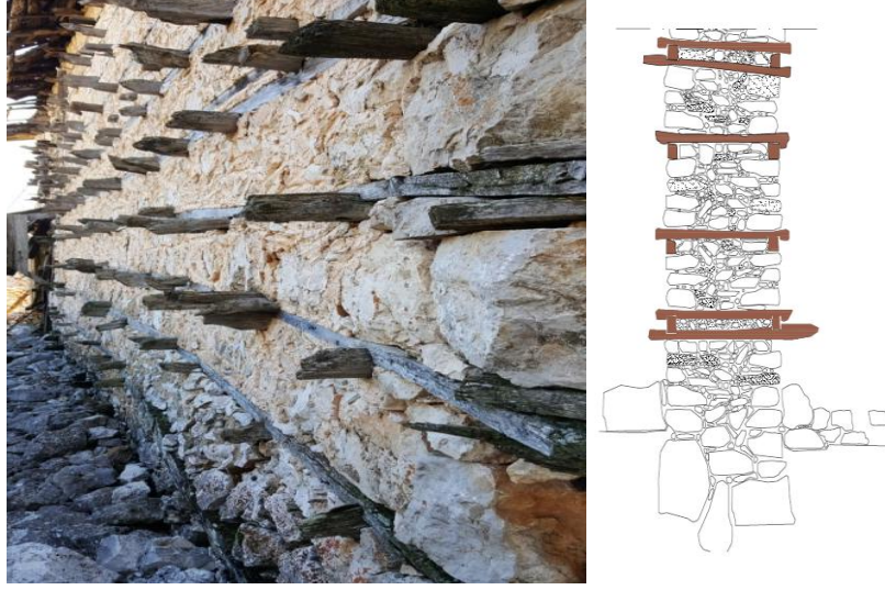
Resim 2. Düğmeli Duvar Tekniği Çizimi
