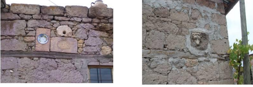
Resim 3. Meskenlerin Cephelerinde Devşirme Malzeme Kullanımı (D. Aydın)
