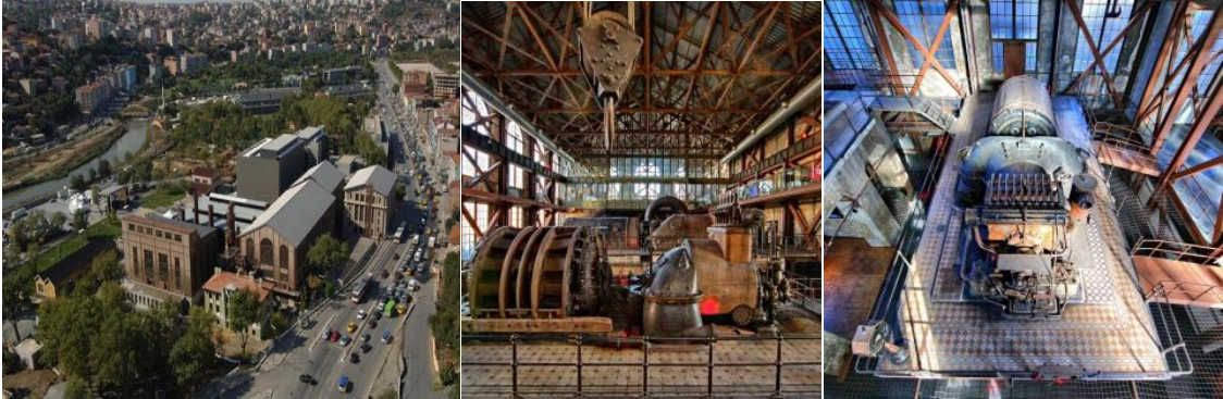
Resim 4. Silahtarağa Elektrik Santrali (Santral İstanbul Enerji Müzesi)
