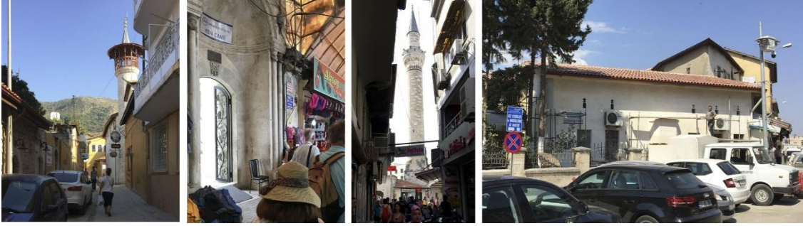
Şekil.9 İbadet Yapılarındaki Uyumsuz Eklentiler (Diker, 2018)
