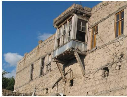
Resim 2. Cephede Konsol Yaparak Sonlanan “Tahtaboş” Mekânı (D. Aydın).
