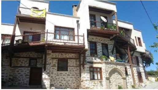
a) Sille Konağı
