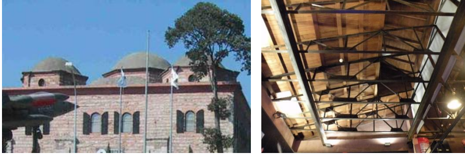
Şekil 11. Restorasyon Sonrası Cephe ve İç Kısım Fotoğrafları
