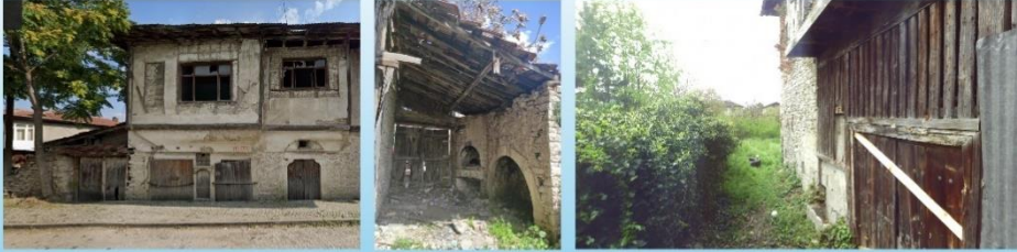
Yapının Arka Taraftaki Bahçesi ve Bahçe Duvarlarının Üst Örtüsü
