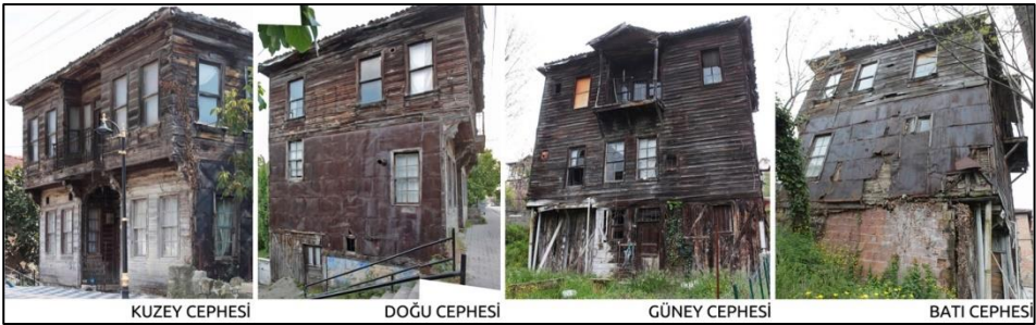
Şekil 9. 417 ada, 57 parseldeki yapının cephe fotoğrafları. (Saruhan, 2019)
